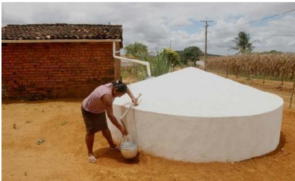
Figura 6 – Cisterna para coleta de água da chuva. Observe os canos ligados à calha junto ao telhado
