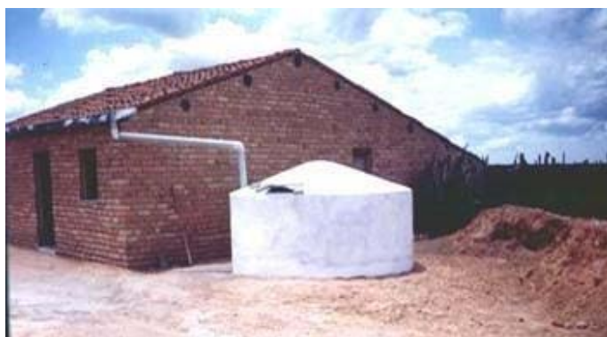
Figura 5 – Cisterna para coleta de água da chuva junto à casa
