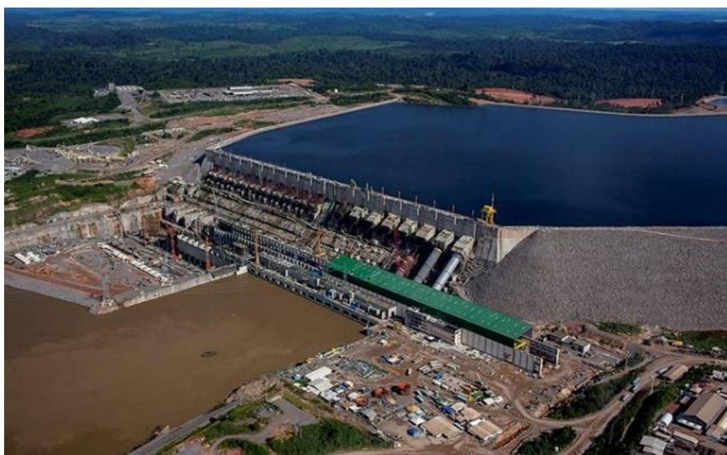
Figura 1 – Usina de Belo Monte
