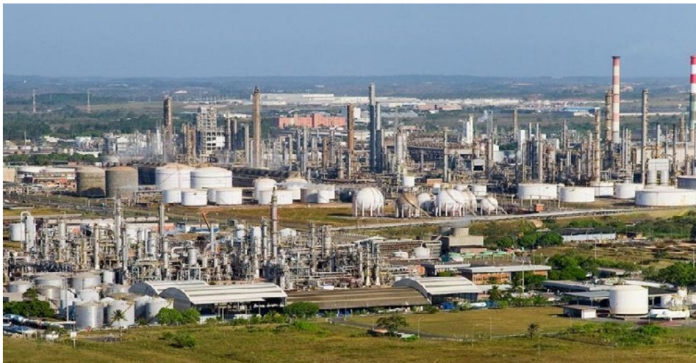
Figura 1 – Polo industrial de Camaçari
