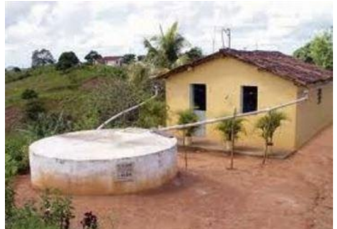
Figura 2 – Casa com poço artesiano
